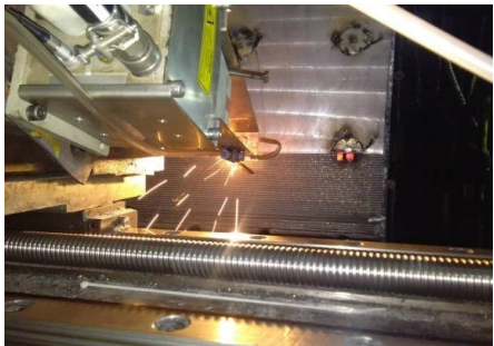
轧机牌坊现场修复
